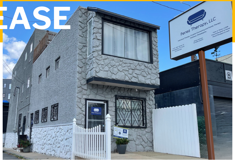
Oficina Principal en las Avenidas Frankford & Delaware
